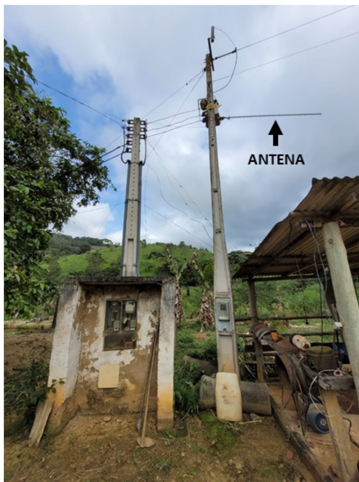
Figura 8 – Sistema de telemedição com antena de alto ganho para captação de sinal 3G.
